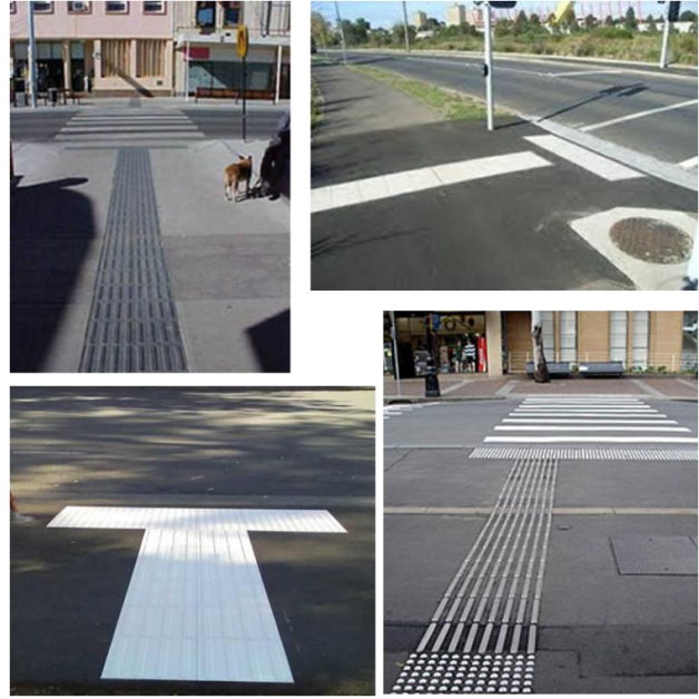
Fotoğraf 1: Yaya geçidine kılavuz izle yönlendirme yapılmalı ve taşıt yolu öncesinde 80 cm derinliğinde ve yaya geçidi genişliğinde uyarıcı yüzey uygulanmalıdır.
